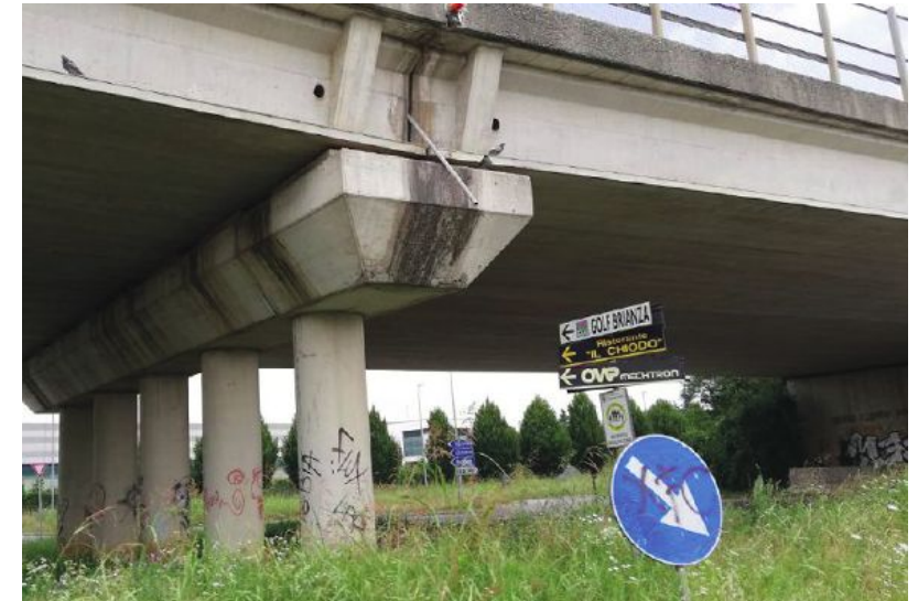
Qui sopra, uno scorcio del cavalcavia della Sp177, in territorio di Usmate Velate. Sopra, il cavalcavia di Vimercate che collega Sp2 e Sp45
