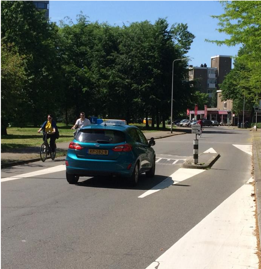
Strettoia con varchi ciclabili – Utrecht, Paesi Bassi
