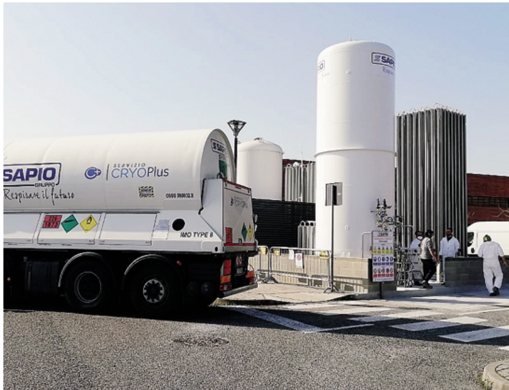
Il nuovo serbatoio, che si aggiunge a quello esistente che si intravede dietro
