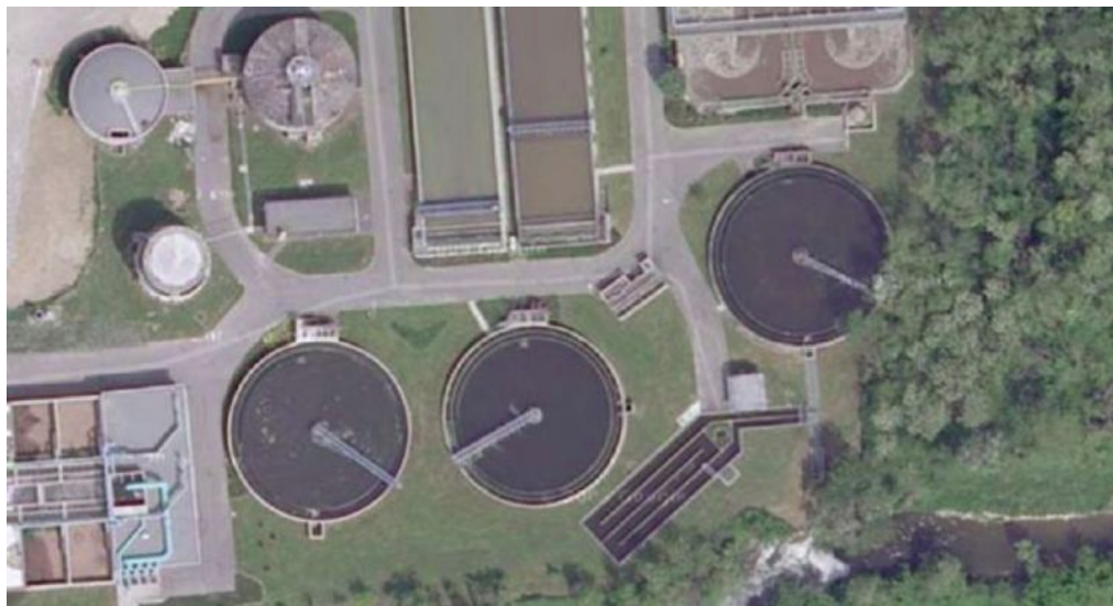
Una veduta dall'alto dell'impianto di depurazione di BrianzAcque, a Vimercate
