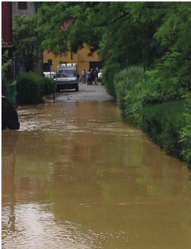
Via San Rocco allagata in occasione di una delle piene del Molgora
