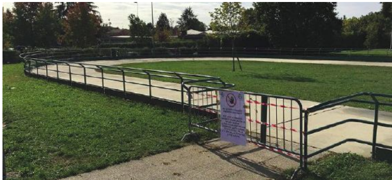
La pista di pattinaggio di via Fiume chiusa per i lavori in corso
