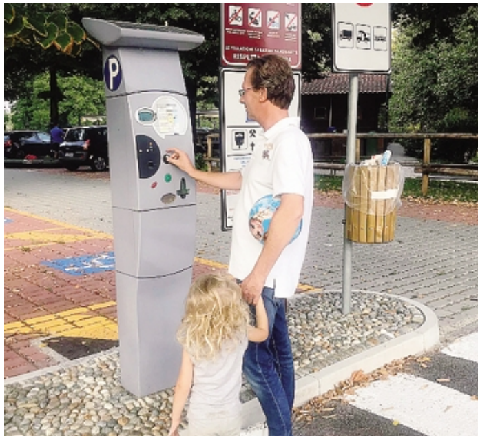
Una colonnina per il pagamento con pannello fotovoltaico di alimentazione
