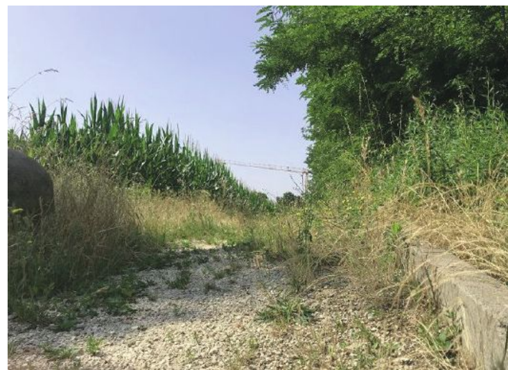
Qui accanto e sotto, le eloquenti immagini dello stato di abbandono della ciclabile di Rossino. Dovrebbe avere un calibro di due metri e mezzo, ma è ridotta ad un viottolo coperto da sterpaglie e rovi
