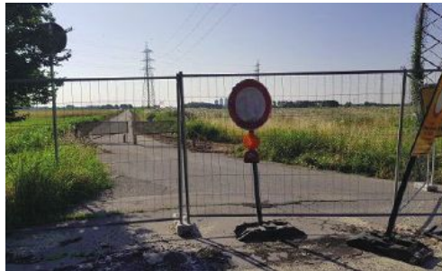
Il cantiere della ciclabile
