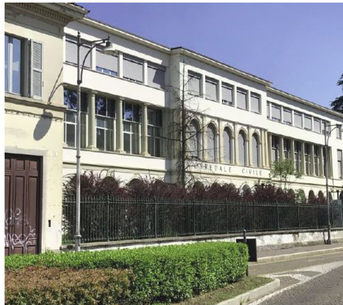
Uno scorcio del complesso delle vecchie Medicine di via Cereda. Lo stabile sta ormai cadendo a pezzi
