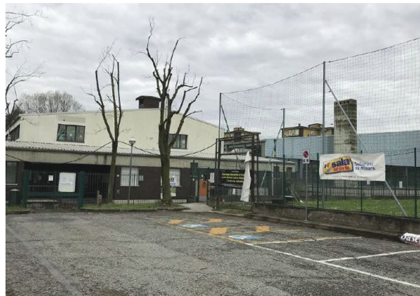
L'esterno della piscina comunale di via degli Atleti chiusa dal luglio dello scorso anno. Una situazione d'abbandono che ha favorito l'in-cursione dei ladri alla ricerca di rame
