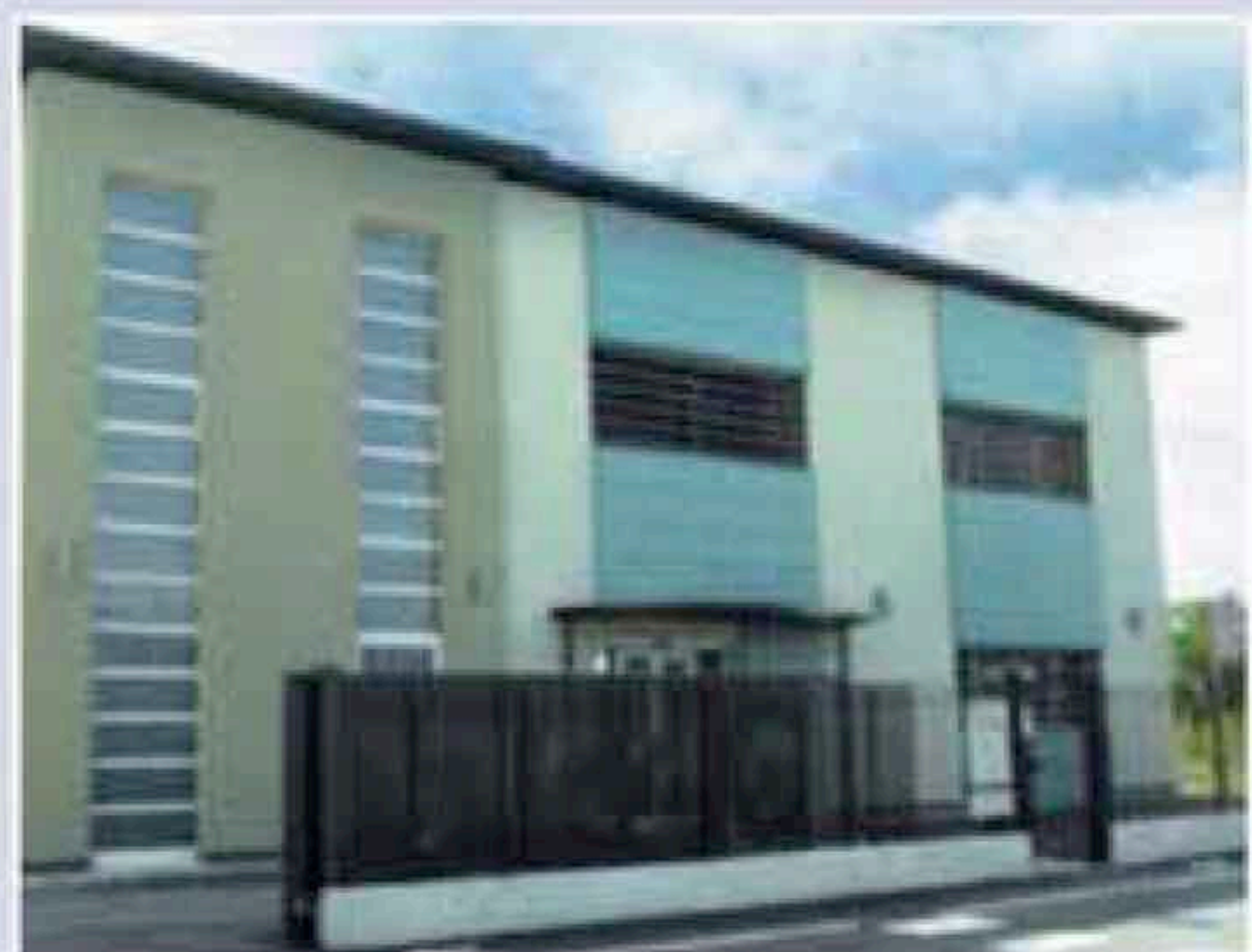
La struttura inaugurata nel 2015
