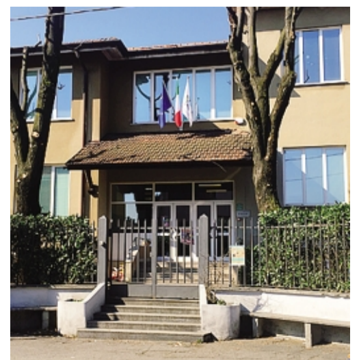
L'ingresso della scuola primaria Ada Negri Foto Agostoni
