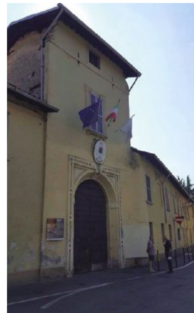
Palazzo Trotti, sede del Municipio
