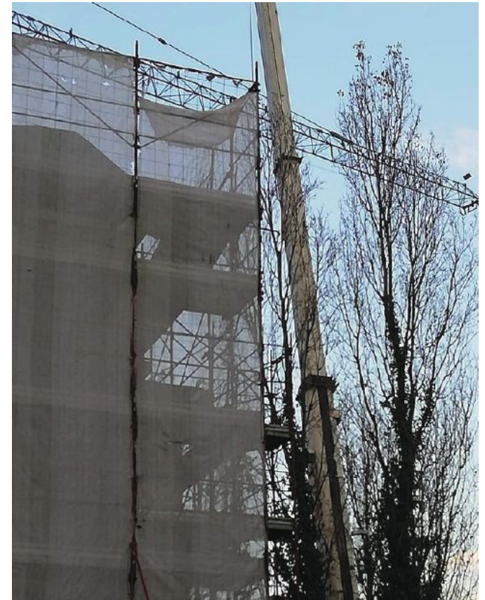
Le operazioni di rimozione della gru dal cantiere di via Garibaldi incominciate martedì scorso
