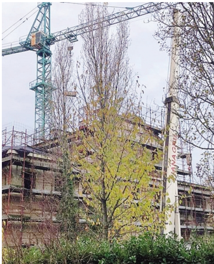
Le fasi di smontaggio della gru Foto Boni
