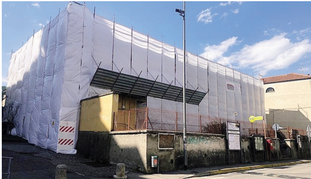
Il cantiere è la messa in opera del progetto approvato col bilancio partecipato 2019 Foto Boni
