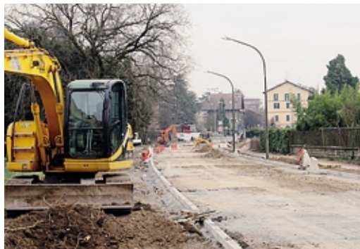
Il cantiere di via Rota al centro di polemiche sui lavori di recupero
