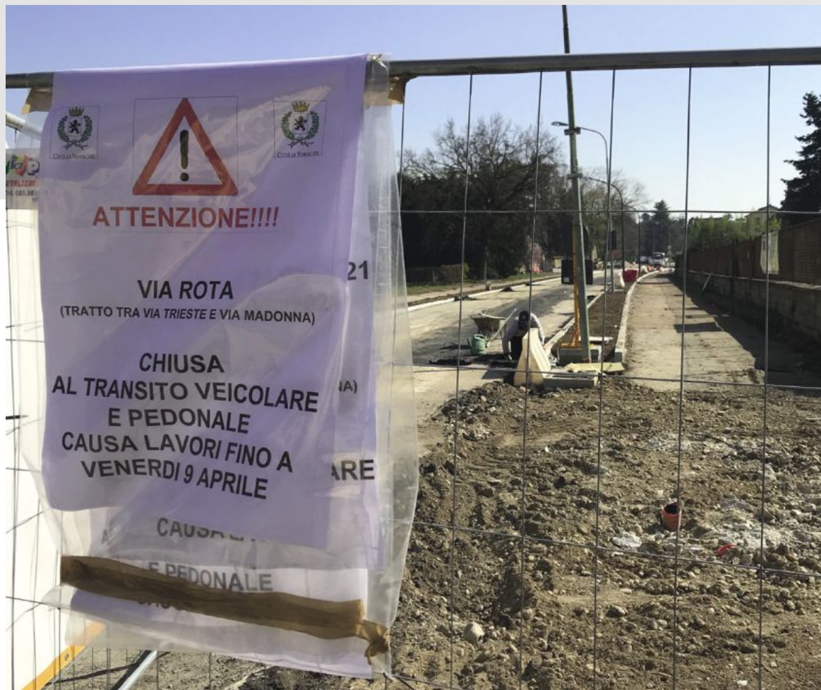
Nonostante la mozione delle opposizioni e la lettera della Soprintendenza le opere nel cantiere di via Rota, a Oreno, proseguono. La data di fine lavori è stata posticipata al 9 aprile
