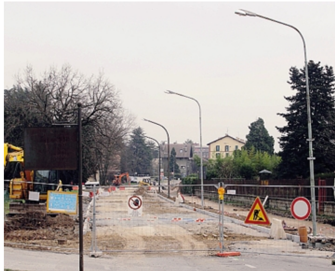
Il cantiere di via Rota a Oreno
