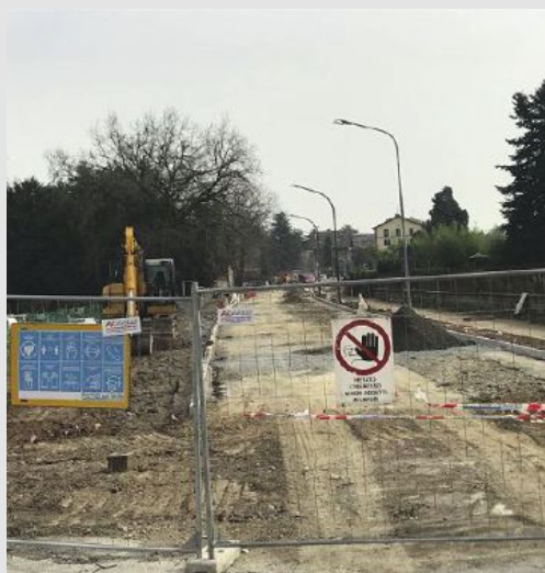
Il cantiere per la riqualificazione del tratto orenese di via Rota
