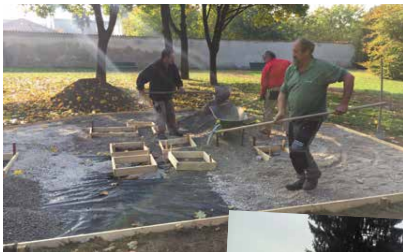
Parco della Villa Volontieri: nella foto qui a sinistra la preparazione del primo spazio per la nuova area giochi nella foto qui sotto la seconda area dedicati ai giochi pronta per l'installazione
