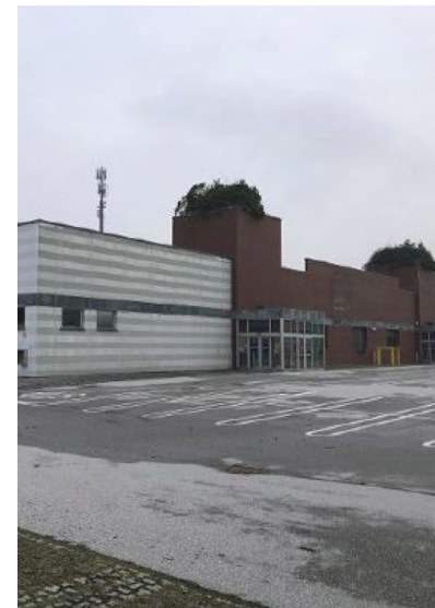
Lo stabile della vecchia Esselunga di via Toti. Resterà in piedi per altri due anni
