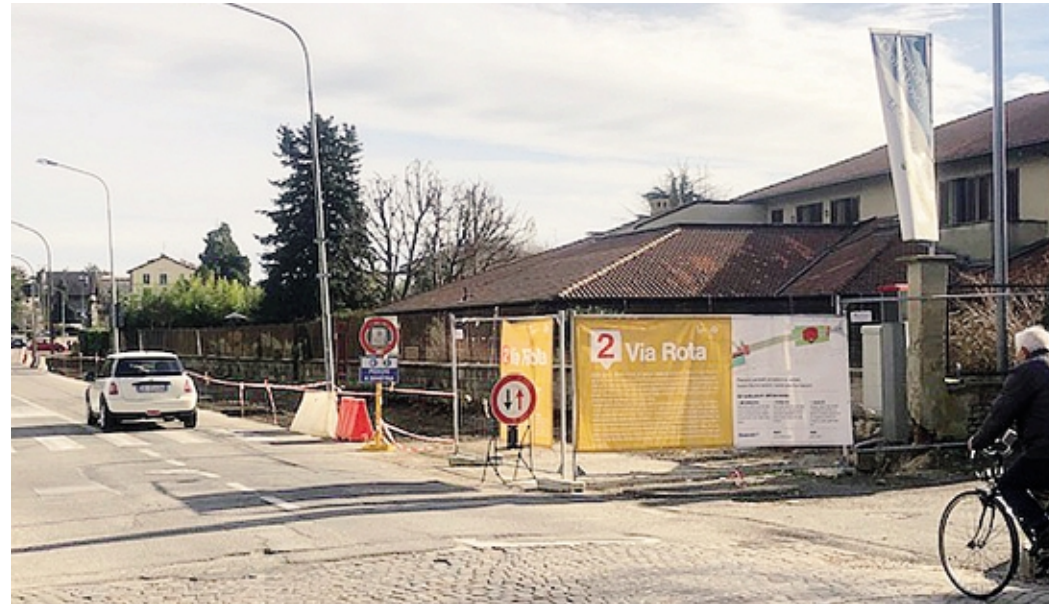
I lavori per la riqualificazione di via Rota dovrebbero terminare agli inizi di aprile Foto Boni
