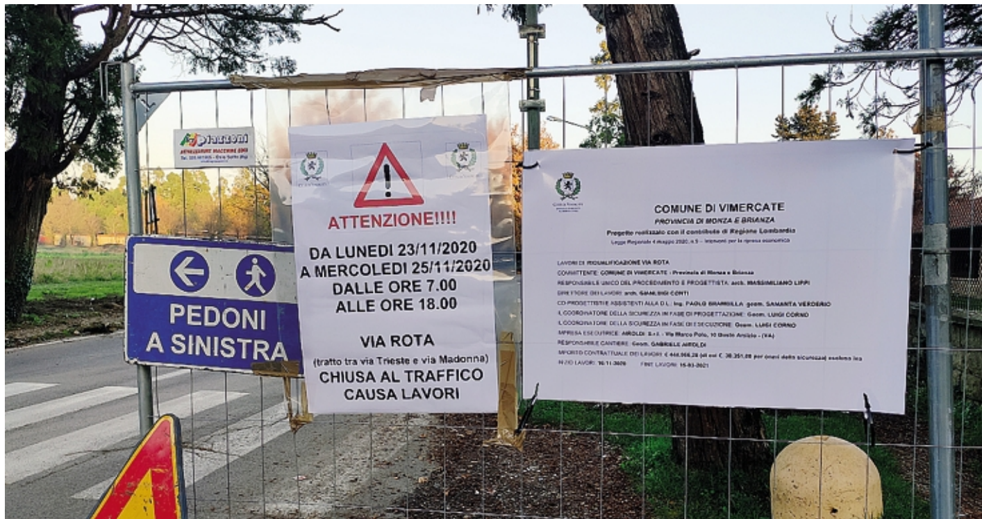
Cantiere pronto a partire Foto Galbiati
