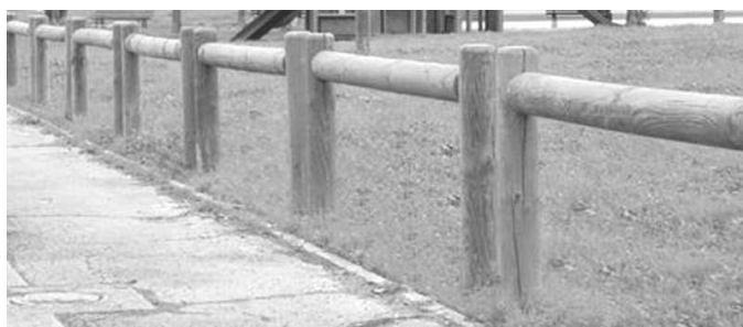
Steccato aperto con singola fila di pali
