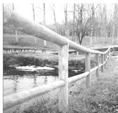
Steccato aperto con due file di pali a correre
